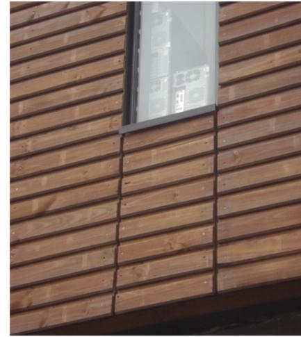
▲ Unión correcta de maderas con separación adecuada.
