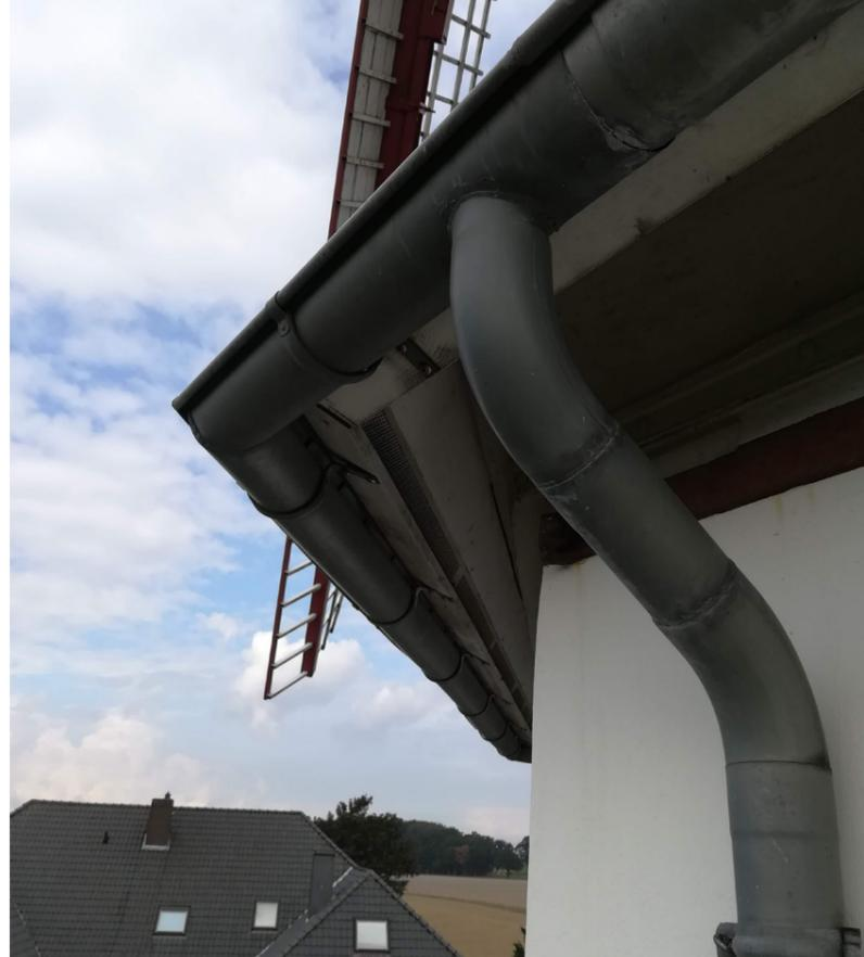
▶ Canaletas que asegura una adecuada evacuación del agua en el desfase de la cubierta.
