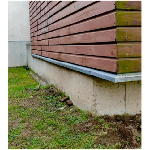
▲ Terminación adecuada de entablado con cortagotera.
