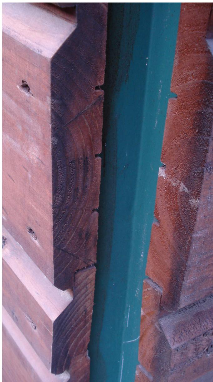
◀ Unión correcta en esquina con separación del entablado y uso de forro metálico.
