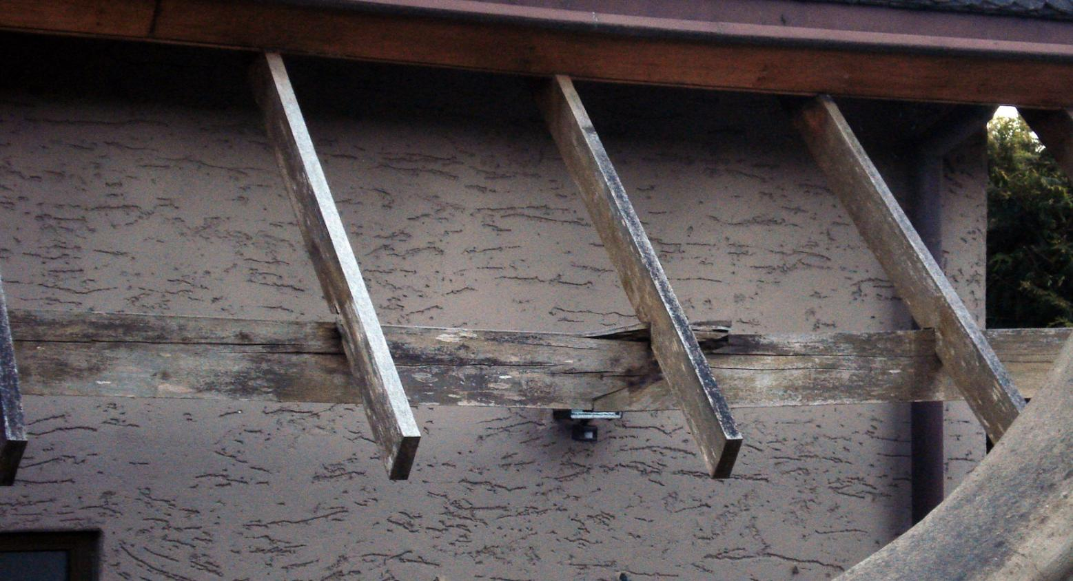
▲ Maderas expuestas directamente a la radiación solar se deterioran.
