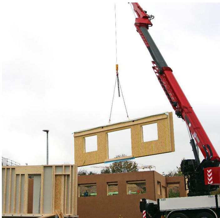
*Proceso de montaje de una vivienda con elementos prefabricados de madera.*
